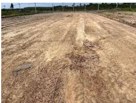
รูปที่ 2-3 การปรับถมพื้นที่ก่อสร้าง
