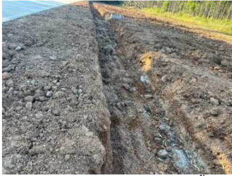
รูปที่ 2-20 การขุดลอกการระบายน้ำ
