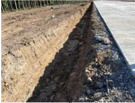
รูปที่ 2-5 ร่องระบายน้ำฝนในพื้นที่ก่อสร้าง
