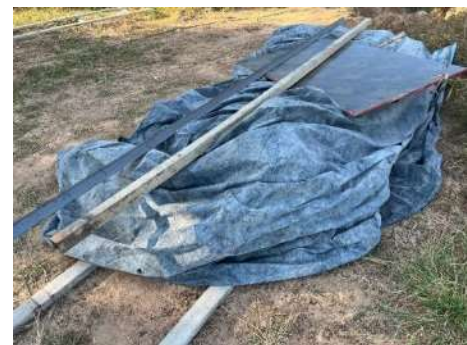
รูปที่ 2-19 กองวัสดุก่อสร้างที่มีการปิดคลุม
