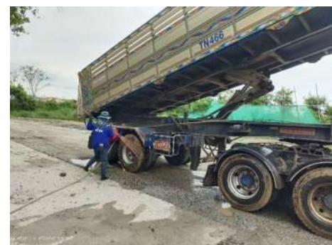
รูปที่ 2-17 การล้างล้อรถบรรทุก
