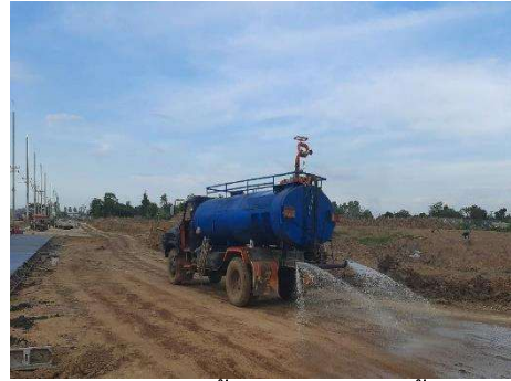
รูปที่ 2-6 การฉีดพรมน้ำบริเวณทางเข้าพื้นที่ก่อสร้าง
